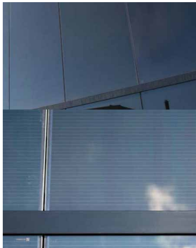
Figur 27: Integrerade solceller i al-plåt (Soltech).
